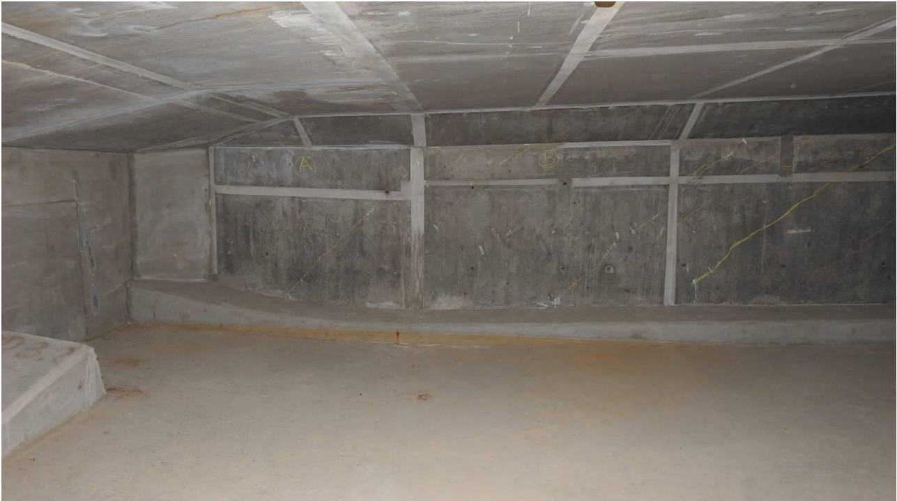
Rys. nr 18. Rysy przepony między obiektami – widok od strony wewnętrznej
