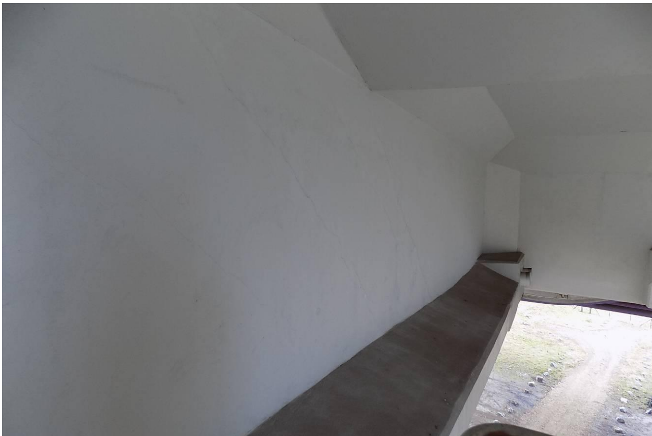
Rys. nr 20. Rysy przepony od strony zewnętrznej – widok od strony zewnętrznej
