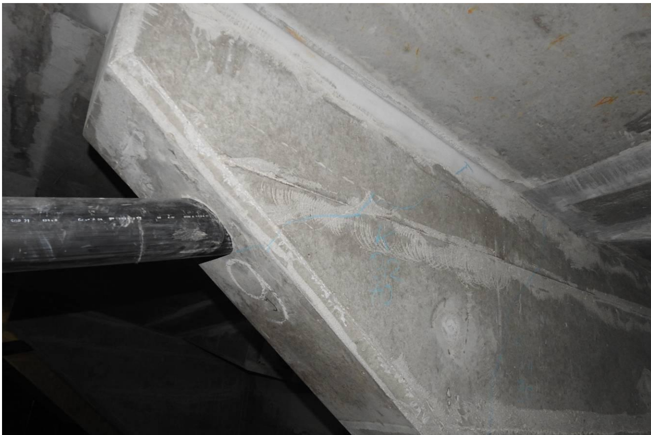
Rys. nr 22. Rysa na żebrze sprężenia poprzecznego
