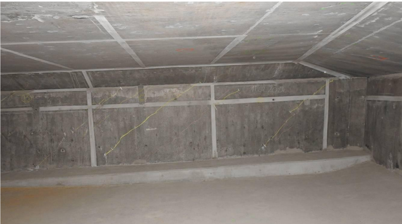
Rys. nr 19. Rysy przepony między obiektami – widok od strony wewnętrznej
